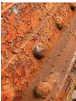
232 pav. Geležies ir plieno korozija
