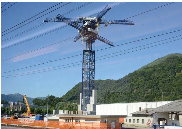
4.12 pav. 75 m aukščio gravitacinės baterijos prototipas Šveicarijoje (failas: Energy Vault Test Tower 2021.jpg. CC BY-SA 4.0)
